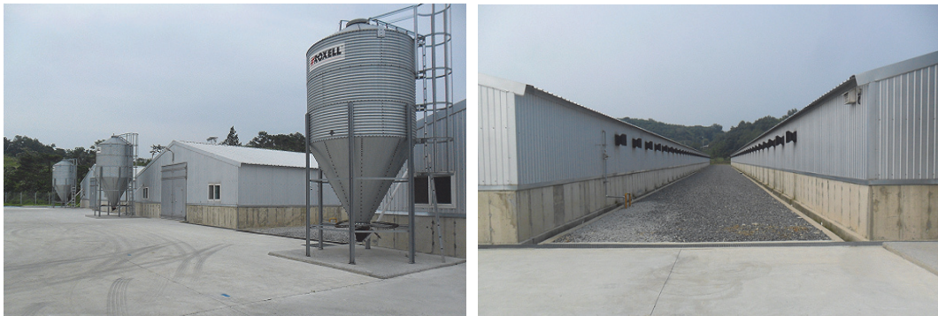
그림 1-6. 계사 주변에 콘크리트로 포장하여 차단방역이 잘 된 계사
